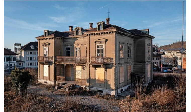
Die Villa Schmid ist ein Musterbeispiel einer Fabrikantenvilla. Sie benötigt dringend eine Renovation.
