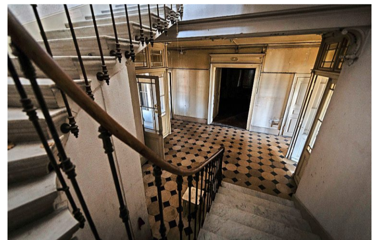
Die Sanierung wird tiefe Eingriffe nötig machen.
